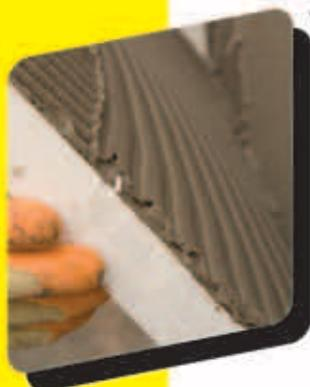
Placas de poliestireno expandido para el sistema **webertherm EIFS**.
