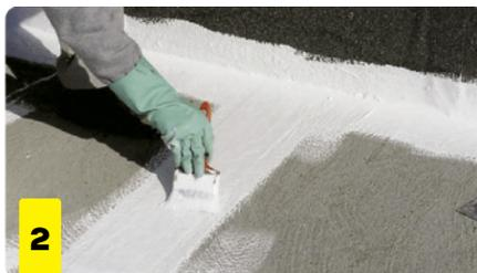
2 . Mezclar el producto, hasta homogeneizar. Aplicar 1 mano de imprimación diluida, con rodillo, pincel o brocha. Dejar secar entre 2 y 4 horas dependiendo de la humedad y temperatura ambiente.
