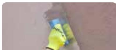
Extender el material con llana metálica de manera uniforme sobre la superficie hasta lograr el espesor determinado por la granulometría del producto.
