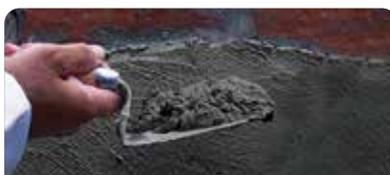
Aplicar con cuchara de albañil en capas sucesivas hasta obtener un espesor de aproximadamente 1,5 cm. Reglear y luego retirar las guías. Rellenar con el mismo material, presionando y asegurándose de no dejar huecos. De ser necesaria otra capa esperar entre 1 y 3 horas de secado, dependiendo de la humedad y temperatura ambiente.
