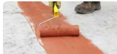
Soldar los solapes entre paños calentando con soplete, y luego, con una cuchara de albañil, presionar y distribuir el asfalto de exudado para sellar la unión. Aplicar **Megaflex pintura geotrans** toda la superficie para revestir el geotextil y protegerlo de los rayos solares y del tránsito peatonal.
