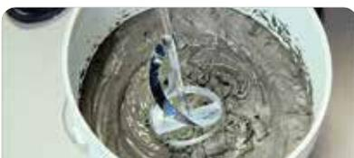
Colocar agua limpia en el balde, luego agregar **weber superflex** paulatinamente (6 l por bolsa aprox.), mezclar manualmente o con batidor eléctrico (500 rpm) hasta obtener una pasta homogénea. Dejar reposar 5 minutos.
