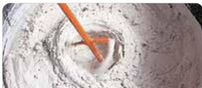
Amasar con aproximadamente 5 a 6 litros de agua limpia por bolsa de 25 kg. Mezclar manual o mecánicamente hasta conseguir una masa homogénea.
