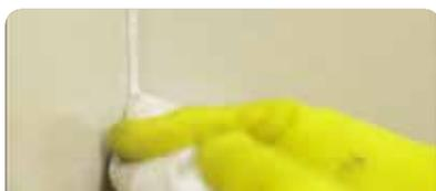
Aplicar el producto sobre la junta, asegurándose que ingrese el material en su profundidad y evitando excesos sobre la pieza. Con espátula de goma repasar sobre la junta retirando exceso de producto y generando la terminación.
