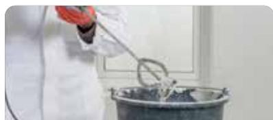
Mezclar con batidor manual el contenido del envase para evitar la sedimentación del producto. Limpiar a fondo la superficie a aplicar, eliminando polvo y suciedades. En caso de existir partes flojas, eliminarlas y reparar.
