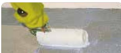
**2. Superficies Nuevas:** aplicar 1 mano de **tacurú fijador/sellador al agua**. Reparar imperfecciones menores con **tacurú endurecido plástico**. Imprimir y lijar. **Superficies Pintadas:** aplicar 1 mano de **tacurú fijador/sellador al agua**. Reparar imperfecciones con **tacurú endurecido plástico**, lijar.
