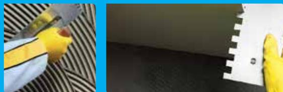
En el caso de necesitar realizar un doble encolado, calculá un + 50 %. Ejemplo: llana N° 10 doble encolado = 5 + 2,5 = 7,5 kg/m<sup>2</sup>
