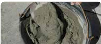
Como base niveladora para revestimiento: extender con llana metálica el **webertherm base coat** gris, en un espesor de 2 a 3 mm. Aplicar una malla de vidrio y con llana metálica otra capa en un espesor tal que cubra la malla por completo. Terminar con revestimiento acrílico o cementicio.
