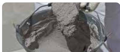
Amasar con aproximadamente 6/7 l de agua limpia por bolsa de 25 kg, manual o mecánicamente, hasta lograr una pasta homogénea. Dejar reposar aproximadamente 10 min.
