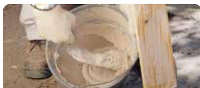
Amasar con aproximadamente 7 l de agua limpia por bolsa de 25 kg, manual o mecánicamente, hasta lograr una pasta homogénea. Dejar reposar aproximadamente 15 min.
