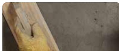
Cubrir con el revoque posterior en el lapso de las 12 y 48h de aplicado el imprimante. Es muy importante respetar el tiempo abierto del producto.
