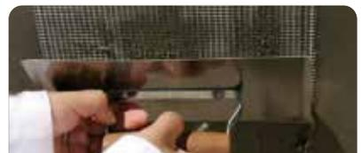
Como revoque base: sobre EPS dar una primera mano de **webertherm base coat** gris, con una llana metálica con un espesor de 2 mm aprox. y dejar orear. Colocar malla de fibra de vidrio y aplicar una segunda capa que cubra la malla.
