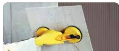
Colocar las piezas, presionarlas y moverlas de arriba hacia abajo, hasta conseguir el aplastamiento de los surcos, dejando la junta recomendada por el fabricante de las piezas (mínimo 3 mm). Luego de 24/48 h, tomar las juntas con **weber prestige** o **weber epoxi plus**.
