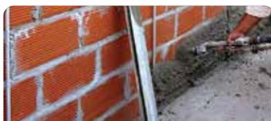
Regular el caudal de la máquina para lograr la consistencia de aplicación adecuada (Doble cámara: 850/900 l/h. Simple cámara: 300/350 l/h). Proyectar de manera uniforme y desde abajo hacia arriba.
