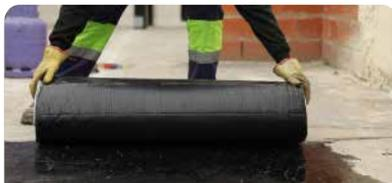
Impermeabilizar con **Megaflex Pintura asfáltica** o **Megaflex Emulsión asfáltica**, según el sustrato, previamente todos los desagües. Luego, colocar los rollos desde la parte más cercana a los mismos hacia la parte más alejada, en forma perpendicular a la pendiente. Extender el rollo a aplicar por completo para verificar su correcta posición. Enrollarlo nuevamente.
