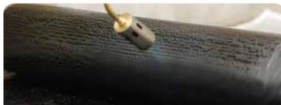
Calentar el rollo con soplete en la porción a aplicar hasta fundir completamente el antiadherente. Desenrollar la parte calentada y ejercer una leve presión para ayudar a la adherencia. Solapar el paño consecutivo no menos de 8 cm en sentido longitudinal. En los extremos de los rollos solapar 15 cm para evitar cualquier filtración.
