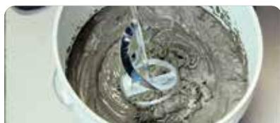
Colocar agua limpia en el balde, luego agregar **weber porcellanato** paulatinamente (6 l por bolsa aprox.) y mezclar manualmente o con batidor eléctrico (500 rpm) hasta obtener una pasta homogénea. Dejar reposar 5 minutos.
