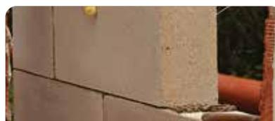
Como puente de adherencia: humedecer la superficie. Colocar **weber celublock** con llana dentada N° 6. Una vez que el material haya secado, aplicar **weber mix I** o **weber mix E**.
