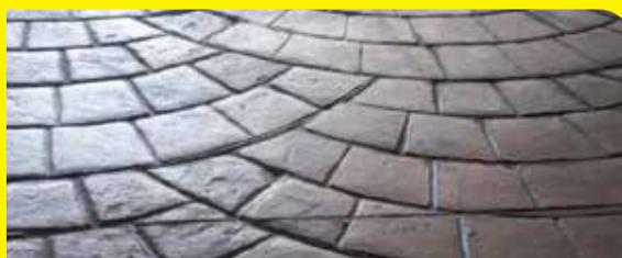
La técnica del estampado o impresión de pisos consiste en, una vez colado el mortero o espolvoreado el hormigón (según si se estampará sobre weber alisado color o weber print XC), poner sobre la superficie aún plástica moldes flexibles de diversas texturas (adoquín, laja, baldosas, etc.) presionando y levantando para dejar el diseño del molde impreso sobre la superficie. Los moldes de estampado se fabrican en diversos tamaños y formas. Otorgan textura y diseño.
