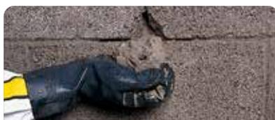
Aplicar realizando presión con los dedos, asegurándose que el producto vaya cubriendo desde el fondo hacia adelante. Realizar este procedimiento hasta completar el orificio. De ser necesario mantener la presión de manera sostenida entre 40 segundos y 1 min.
