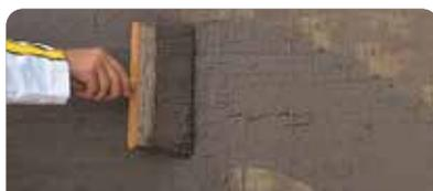
Una vez que el brillo del agua aplicada sobre el soporte haya desaparecido, aplicar la primera mano con pincel o brocha. Dejar secar entre 3 y 4 horas dependiendo de la humedad y temperatura ambiente.
