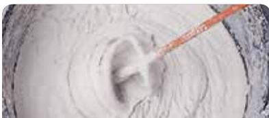
Amasar con aproximadamente 6/7 l de agua limpia por bolsa de 25 kg, manual o mecánicamente, hasta lograr una pasta homogénea. Dejar reposar aproximadamente 10 min.
