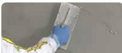
Extender el material uniformemente con llana metálica hasta conseguir el espesor deseado. Apretar con fuerza sobre el sustrato para lograr tapar las imperfecciones de la superficie.
