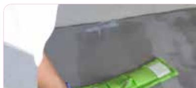
Para asegurar la durabilidad del sistema proteger con 2 manos de weber protector base. Finalizar el proceso y mantener con para lograr una terminación perfecta.
