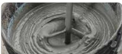
Mezclar manual o mecánicamente una parte del componente sólido con una parte del componente líquido, hasta obtener un color y consistencia homogéneos. Se recomienda ir agregando paulatinamente la parte líquida durante el mezclado para evitar la formación de grumos.
