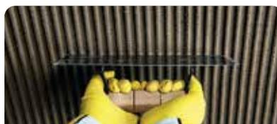
Extender sobre el soporte en paños pequeños de 1 m<sup>2</sup> aprox. peinando con una llana dentada para regularizar el espesor y proceder a la colocación. Si fuera necesario, aplicar una capa de mezcla sobre la pieza con la parte lisa de la llana.
