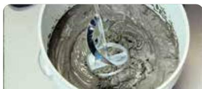
Colocar agua limpia en el balde, luego agregar **weber piso sobre piso 12 hs** paulatinamente (6 l por bolsa aprox.) y mezclar manualmente o con batidor eléctrico (500 rpm) hasta obtener una pasta homogénea. Dejar reposar 5 minutos.
