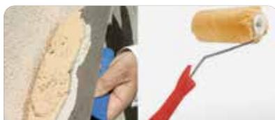
Extender el revestimiento con llana metálica, hasta lograr el espesor determinado por su granulometría.
