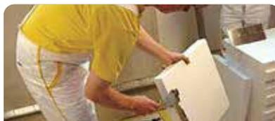
Como adhesivo: extender el **webertherm base coat** gris sobre la pared y el reverso de la placa, con la parte ciega de la llana N.º 10. Ranurar con la parte dentada. Apoyar la placa y presionar.
