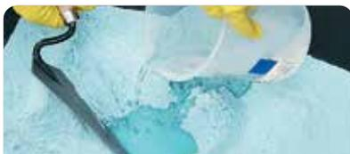
Colocar agua limpia en el balde, luego agregar weber veneciano paulatinamente (7 l por bolsa aprox.), mezclar manualmente o con batidor eléctrico (500 rpm) hasta obtener una pasta homogénea y de coloración uniforme. Preparar solo de a 1 balde chico para garantizar la vida de la pasta.
