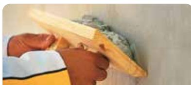
Extender con frataso en forma lineal hasta lograr el espesor deseado. Si es necesaria una segunda extensión, esperar a que la primera haya secado ligeramente.
