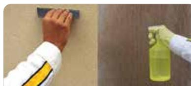
Desgranar con el peine de frentista de arriba hacia abajo. Finalmente, quitar el material desgranado con cepillo de cerda blanda. Curar el material. Verificar que el material haya fraguado y tratar el revestimiento con **weber siliston S** para disminuir el mantenimiento y aumentar la durabilidad.
