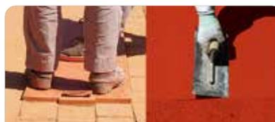
En el momento que ya no se presente agua en la superficie pero el mortero esté en estado plástico, alisar o estampar mediante moldes. Cuando ya no presente rastros de humedad visible, limpiar eliminando el polvo y sellar la superficie mediante el uso de weber sellador de pisos.
