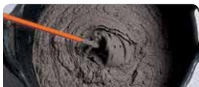
Amasar con aproximadamente 4 litros de agua limpia por bolsa de 25 kg. Mezclar manual o mecánicamente hasta conseguir una masa homogénea.
