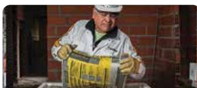
Mezclar el producto a razón de 5,5 a 6 litros de agua por bolsa (aplicación manual o maquinada) o 650 l/h aprox. en máquina revocadora M-tec Duo Mix. Una vez mezclado, comprobar si la fluidez es la indicada, con el weber medidor de fluidez.
