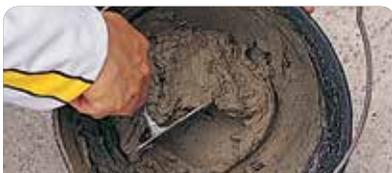
Colocar agua limpia en el balde, luego incorporar **weber refractarios** y mezclar manual o mecánicamente hasta obtener una pasta homogénea (1 l de agua limpia cada 5 kg).
