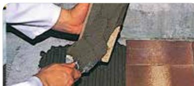
Dejar reposar 5 min., remezclar y extender sobre el soporte y sobre el revestimiento a colocar. Se debe regularizar el espesor con una llana de 12 mm.
