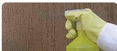
Aplicar una mano a soplete a presión, pulverizador, rodillo o pincel hasta saturar bien la superficie. Luego aplicar una segunda mano del mismo modo.
