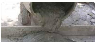
Volcar la mezcla sobre el contrapiso y alisar con cuchara para cubrir la totalidad de la superficie. Aplicar en paños no mayores a 1 m<sup>2</sup>, para mantener la pegajosidad de la superficie de la mezcla.
