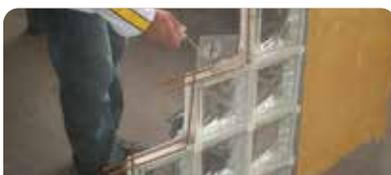
Extender **weber glass** sobre los bloques de vidrio (ambas caras). Presionar hasta el aplastamiento del material. Utilizar espaciadores. Colocar varillas metálicas conforme a las recomendaciones del fabricante de bloques.
