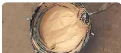
Amasar **weber super iggam** con aprox. 6,5 l de agua por bolsa de material, manual o mecánicamente, hasta lograr una pasta homogénea y dejar reposar entre 5/10 min.
