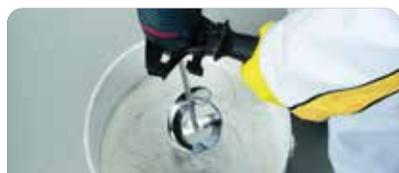
Colocar agua limpia en el balde, luego agregar **weber piscinas** paulatinamente (7 L por bolsa aprox.), mezclar manualmente o con batidor eléctrico (500 rpm) hasta obtener una pasta homogénea y dejar reposar 5 minutos.
