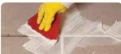
Con ayuda de una espátula o llana de caucho, aplicar en juntas de 2 a 15 mm en forma diagonal, presionando para lograr un completo rellenado. Retirar el excedente.
