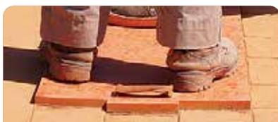
Imprimir ejerciendo presión sobre el molde. Levantar, y continuar imprimiendo.
