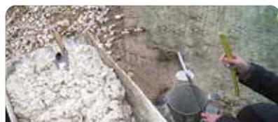
Preparar (cuando sea posible) la mezcla en seco, en un lugar limpio para evitar contaminación, agregar la cantidad de agua que sea necesaria y mezclar manual o mecánicamente.
