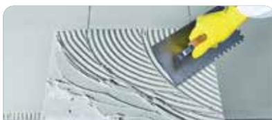
Extender el pegamento con llana dentada sobre el soporte y sobre la pieza. Siempre orientando la aplicación del adhesivo hacia el lado más corto de la pieza.
