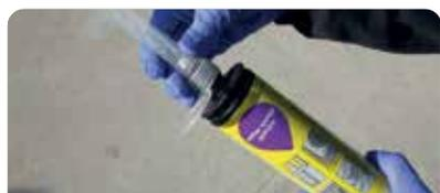
Retirar la tapa del envase y enroscar la boquilla mezcladora para su aplicación. Colocar el envase en la pistola aplicadora. Si el sustrato donde instalará el anclaje no es macizo se debe utilizar la canastilla para contener el material.
