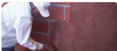
Aplicar el producto con cuchara de albañil, logrando un espesor mínimo de 5 mm. Presionar bien el material.
