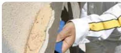
Extender el material con llana metálica de manera uniforme sobre la superficie hasta lograr el espesor deseado. Se deben aplicar dos manos del producto con llana metálica.
