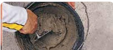
Preparar la superficie a revocar con guías, fajas secas o húmedas. Amasar **weber mix E** utilizando de 4,5/5,5 l de agua por cada bolsa de 30 kg, manual o mecánicamente, hasta lograr una pasta homogénea.
