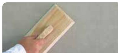
Como reparación de morteros y/o carpetas aplicar el material, previa colocación del promotor de adherencia weberprim IC52 fibrado.
