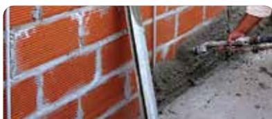
Regular el caudal de la máquina para lograr la consistencia de aplicación adecuada (doble cámara: 800/850 l/h. Simple cámara: 250/300 l/h). Proyectar de manera uniforme y desde abajo hacia arriba.
