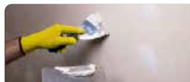
**3. Superficies Nuevas:** con llana, extender capa delgada de abajo hacia arriba. Dejar secar y lijarse. De necesitar aplicar 2° mano, dejar secar 24 hs y volver a lijarse.
