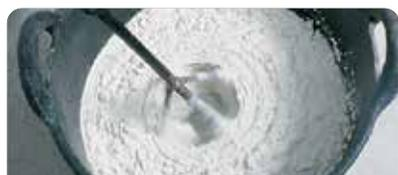
Amasar **weber glass** con 1 l de agua limpia por cada 5 kg de material hasta obtener una pasta homogénea, firme y sin grumos. La mezcla puede ser manual o mecánica. Dejar reposar 5 min.
