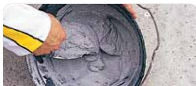
Colocar agua limpia en un balde y luego agregar **weber yeso GF** paulatinamente. Utilizar un volumen de agua cada 2 volúmenes de **weber yeso GF**. Mezclar manual o mecánicamente hasta obtener una pasta homogénea.
