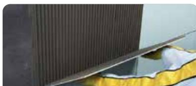
Extender sobre el soporte en paños pequeños de 1 m<sup>2</sup> aprox. peinando con una llana dentada para regularizar el espesor. Si fuera necesario, aplicar una capa fina del material sobre la pieza con la parte lisa de la llana.
