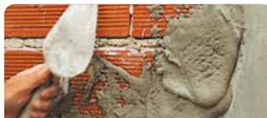
Aplicar al sustrato con cuchara de albañil en capas sucesivas hasta obtener un espesor aprox. de 1,5 cm. Reglear. Luego retirar las guías, rellenar con material presionándolo y asegurándose de no dejar huecos.
