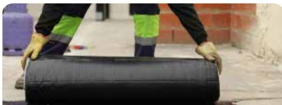
Impermeabilizar con **Megaflex Pintura asfáltica** o **Megaflex Emulsión asfáltica**, según el sustrato, previamente todos los desagües. Luego, colocar los rollos desde la parte más cercana a los mismos hacia la parte más alejada, en forma perpendicular a la pendiente. Extender el rollo a aplicar por completo para verificar su correcta posición. Enrollarlo nuevamente.
