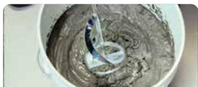
Colocar agua limpia en el balde. Luego agregar **weber impermeable con ceresita paulatinamente** (5,5-6 l por bolsa aprox.) y mezclar manualmente o con batidor eléctrico (500 rpm) hasta obtener una pasta homogénea. Dejar reposar 5 minutos.
