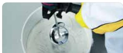
Colocar agua limpia en el balde, luego agregar **weber slim + 1000** paulatinamente (5,5 l por bolsa). Mezclar hasta obtener una pasta homogénea. Dejar reposar 5 minutos.
