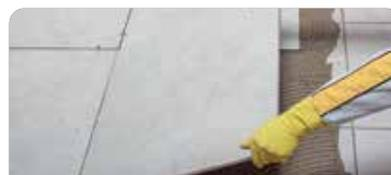
Colocar las piezas, presionarlas hasta conseguir el aplastamiento de los surcos, dejando la junta recomendada por el fabricante de las piezas (mínimo 3 mm). Tomar la junta a partir de las 6 h de la colocación con productos de la gama **weber prestige** o **weber epoxi plus**.
