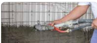
Aplicar sobre el panel, hasta cubrir la malla metálica, asegurándose de que no queden espacios sin cubrir. Luego colocar las guías metálicas. Aplicar la segunda capa cuando la primera comience a "tirar".
