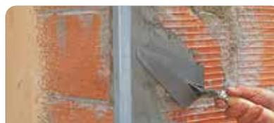
En el caso de anclajes o empotramientos, insertar el elemento y presionar. Luego, alisar con cuchara y fratar para una mejor terminación.
