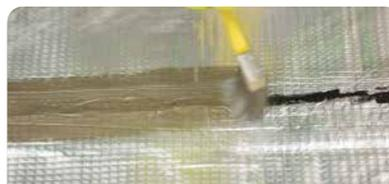
Soldar los solapes entre paños calentando con soplete, y luego, con una cuchara de albañil, presionar y distribuir el asfalto de exudado para sellar la unión. Aplicar **Megaflex pintura aluminizada** para membranas con revestimiento de aluminio y **Megaflex pintura NO CRACK Color** para membranas con revestimiento color, sobre todas las uniones de paños para proteger el asfalto expuesto al soldar.
