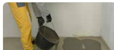
En caso de que se seque, dar nuevamente una mano de **weber primer**. Verter **weber top** sobre el sustrato. Extender y alisar con el rastrillo nivelador. Utilizar el rodillo de púas para eliminar el aire del producto. Dejar secar.
