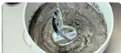
Mezclar el producto con 7,5 litros de agua por bolsa de 25 kg con un batidor eléctrico lento (500 rpm), hasta obtener una pasta fluida y homogénea. Mantener constante esta proporción durante toda la aplicación.
