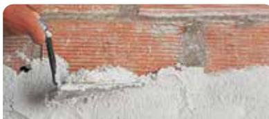
Aplicar con cuchara de albañil hasta obtener un espesor de aproximadamente 2 cm, como mínimo. Reglear y luego retirar las guías. Rellenar los huecos con el mismo material.
