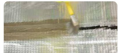
Soldar los solapes entre paños calentando con soplete, y luego, con una cuchara de albañil, presionar y distribuir el asfalto de exudado para sellar la unión. Aplicar **Megaflex pintura aluminizada** sobre todas las uniones de paños para proteger el asfalto expuesto al soldar.
