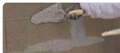
Se deberá repetir esta operación hasta asegurarse que no haya filtraciones de agua. Una vez terminado, alisar con ayuda de una cuchara.
