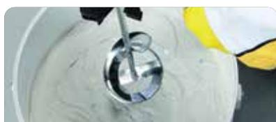
Colocar en un balde una parte de agua y agregar paulatinamente 3 partes de **weber classic**; mezclar manualmente o con batidor eléctrico lento (500 rpm) hasta lograr una pasta homogénea, sin grumos y con desarrollo total de color, y dejar reposar 2 minutos.
