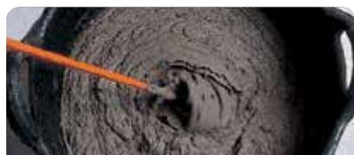
Amasar el material con mezcladora continua, manual o mecánicamente, con aprox. 4,5 a 5,5 l de agua por bolsa (para mortero de asiento), y aprox. 5,2/6,4 l de agua por bolsa (para carpeta).
