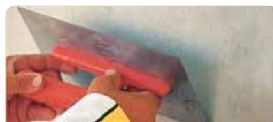
Terminar con llana plástica o metálica en un ángulo de 75° aproximadamente. Hacer sucesivas pasadas ascendentes para lograr un "planchado" de la superficie. De ser necesario, mojar la herramienta con agua limpia.
