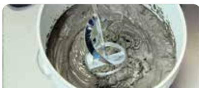
Colocar agua limpia en el balde. Luego, agregar **weber pro** paulatinamente (6 l por bolsa aprox.) y mezclar manualmente o con batidor eléctrico (500 rpm) hasta obtener una pasta homogénea. Dejar reposar 5 minutos.
