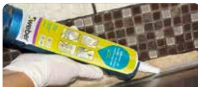
Cortar la punta del pico a bisel en la sección deseada. Introducir el conjunto en la pistola aplicadora.
