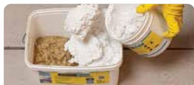
Mezclar la totalidad del componente A con el B hasta obtener una masa homogénea sin agregar agua ni diluyentes. Si se utiliza en forma parcial, mezclar dos partes de A + una de B. La mezcla deberá ser aplicada en su totalidad (retirar el excedente durante la primera hora a partir del mezclado).
