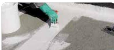
Aplicar una mano de imprimación diluida al 25 % (tres partes de producto y una parte de agua) con rodillo, pincel o brocha. Dejar secar entre 2 y 4 horas dependiendo de la humedad y temperatura ambiente.
