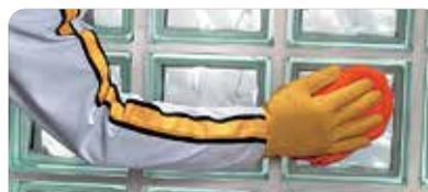
Retirar el exceso de material dejando un remarcado de las juntas. Rellenar faltantes si es necesario. Esperar aprox. 30 min. y efectuar el alisado final con un rejuntador. Terminar la limpieza con una esponja húmeda.
