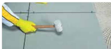
Colocar la pieza y presionar hasta conseguir el aplastamiento de los surcos del adhesivo. Limpiar el excedente de adhesivo sobre las juntas. Respetar la junta entre pieza y pieza según recomendación del fabricante. Transcurridas 24 h tomar la junta con pastinas **weber epoxy plus** o **weber prestige**.
