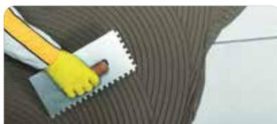
Extender sobre el soporte en paños pequeños de 1 m<sup>2</sup> aprox. peinando con una llana dentada para regularizar el espesor y proceder a la colocación.
