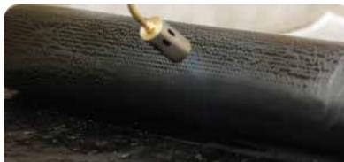
Calentar el rollo con soplete en la porción a aplicar hasta fundir completamente el antiadherente. Desenrollar la parte calentada y ejercer una leve presión para ayudar a la adherencia. Soldar el paño consecutivo no menos de 8 cm en sentido longitudinal. En los extremos de los rollos solapar 15 cm para evitar cualquier filtración.
