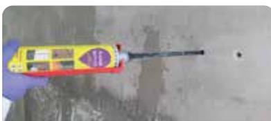
Liberar unos 5 cm de material o hasta que el anclaje se mezcle completamente. Aplicar dentro de la perforación o grieta.
