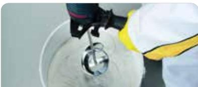
Mezclar homogeneizando los componentes A y B por separado. Mezclar la totalidad del componente A con el B hasta obtener una masa suave y homogénea. Si se utiliza de forma parcial, mezclar dos partes del componente A + una del componente B.
