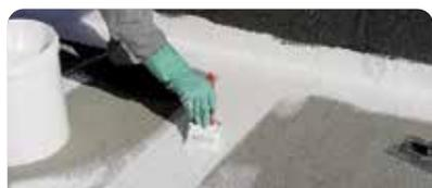
Tratar específicamente los puntos críticos como: desagües, ventilaciones, encuentros de planos, babetas, juntas de dilatación, etc. En estos puntos singulares, es recomendable utilizar una venda geotextil como refuerzo entre la primera y la segunda mano.
