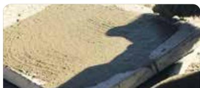
Amasar **weber veredas** manualmente o con trompo (1 bolsa de mezcla con 6 a 7 l de agua) hasta conseguir una masa homogénea. Pintar las piezas con lechada de cemento.
