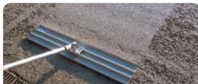
En cada espolvoreo, introducirlo enérgicamente dentro del hormigón mediante el uso de llanas de magnesio o aluminio (incorporación manual), o con el plato del helicóptero (incorporación mecánica).
