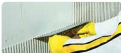
Extender el producto sobre el sustrato con llana dentada hasta regularizar el espesor y proceder a la colocación.
