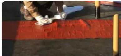
Retirar la primera mitad del antiadherente progresivamente a medida que se va pegando el rollo sobre la superficie. Luego quitar la segunda mitad y pegar. Solapar el paño consecutivo no menos de 8 cm en sentido longitudinal. En los extremos de los rollos solapar 15 cm para evitar cualquier filtración.
