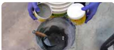
Mezclar los componentes en partes iguales. 1 parte líquida por 1 parte de polvo. Mezclar hasta conseguir una mezcla homogénea.
