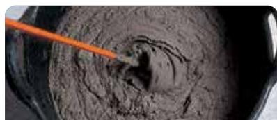
Amasar con aproximadamente 7 a 7,5 litros de agua limpia por bolsa de 25 kg. Mezclar manual o mecánicamente hasta conseguir una masa homogénea.
