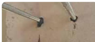
Insertar la fijación entre 3 y 8 minutos de aplicado el material dentro de la perforación. Limpiar el exceso de material.
