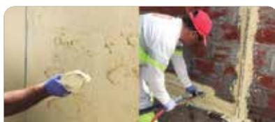
**Aplicación manual:** comenzar aplicando el material presionando con una llana metálica sobre la pared, luego cucharear el resto. **Aplicación proyectada:** comenzar a proyectar desde abajo hacia arriba y de manera uniforme. Espesor máximo de aplicación por capa: 40 mm.
