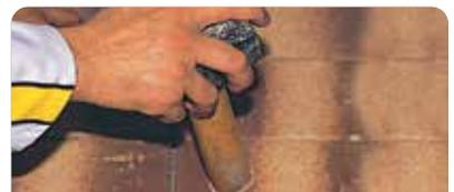
Colocar las piezas refractarias, presionar y nivelar la superficie. Empastinar con el mismo material 48 h posteriores a la colocación y 48 h después se sugiere dar fuego para mejorar el endurecimiento. Proteger de las lluvias hasta tanto no haya endurecido.
