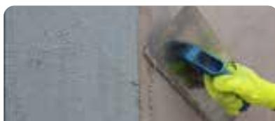
Se pueden aplicar varias manos, dejando que fragüe entre una capa y la siguiente. Para espesores mayores a 3mm, se puede mezclar el producto con hasta un 20% de cemento para mayor consistencia.
