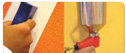
Terminación: dejar orear y cuando el material ha comenzado a endurecer, planchar con llana plástica. Para la opción proyectada, aplicar con máquina tolva mediante una boquilla mediana y compresor con regulador de salida de 35 lb/pulg<sup>2</sup>.
