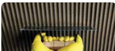
Extender sobre el soporte en paños de 1 m<sup>2</sup>. Para una impermeabilización superior, extender previamente una capa de 2 mm de espesor y dejar orear.
