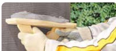
Extender de modo uniforme el producto con frataso de madera en dos manos hasta obtener un espesor de aproximadamente 3 mm.
