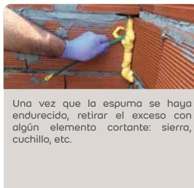
Una vez que la espuma se haya endurecido, retirar el exceso con algún elemento cortante: sierra, cuchillo, etc.
