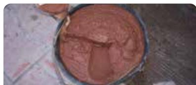
Amasar el material con aproximadamente 5 litros de agua por bolsa de 30 kg durante 5 minutos, hasta obtener una mezcla uniforme y un color homogéneo.
