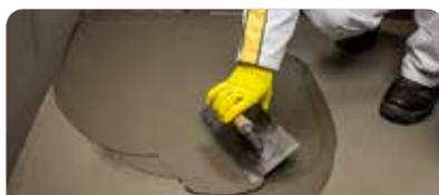
Aplicar la mezcla con llana metálica. Si el sustrato a tratar es con cerámicos existentes, previamente se deben rellenar las juntas con una pasta de consistencia más pesada. Dejar secar, lijar, limpiar bien y proceder a la aplicación con llana metálica del resto del producto con la consistencia sugerida.
