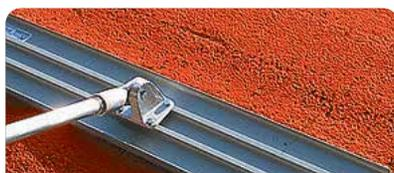
Cuando se haya humectado, alisar con llana tipo palón para que el producto se incorpore al hormigón. Cuando reaparezca el agua superficial, aplicar una segunda carga de producto y su posterior alisado.
