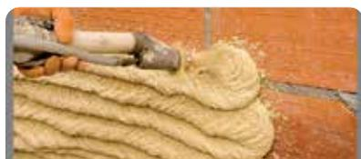
Colocar fajas secas a plomo cada 1,80 m aprox. Regular el caudal de la máquina (Duo Mix: 800 l/h) y proyectar de manera uniforme para lograr una buena distribución. Si la aplicación es manual utilizar 6 l de agua por bolsa.
