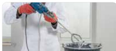
Mezclar el producto con 5 litros de agua por bolsa de 25 kg con un batidor eléctrico lento (500 rpm), hasta obtener una pasta fluida y homogénea. Mantener constante esta proporción durante toda la aplicación. Dejar reposar la mezcla 2 minutos.
