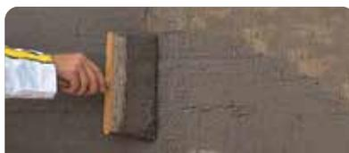
Aplicar una primera mano de manera horizontal. Luego, aplicar segunda mano en sentido contrario, de manera horizontal. El soporte deberá quedar bien cubierto de mezcla.
