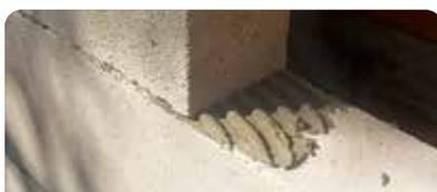
Como mortero adhesivo: colocar **weber celublock** con la llana dentada en la cara horizontal y vertical del bloque. Asentarlo con una masa de goma.
