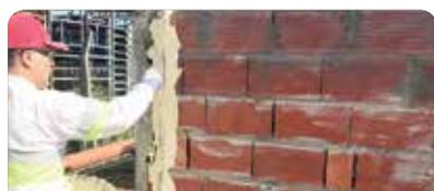
Colocar las reglas metálicas con el mismo material. **Aplicación manual:** preparar la mezcla con agua limpia, aproximadamente 5,5 a 6 l por bolsa. **Aplicación proyectada:** regular la máquina hasta lograr la consistencia adecuada.
