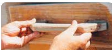
Extender el producto, de abajo hacia arriba, con frataso de madera clara en dos manos hasta obtener un espesor de 4/5 mm. Dejar olear y fratar el material antes de que empiece a endurecer.
