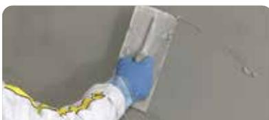
Amasar el producto con agua limpia hasta obtener una masa homogénea. 2,8 l de agua (aprox.) por bolsa de 10 kg. Aplicar con llana metálica hasta conseguir un espesor deseado (1 a 2 mm).
