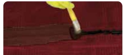
Soldar los solapes entre paños calentando con soplete, y luego, con una cuchara de albañil, presionar y distribuir el asfalto de exudado para sellar la unión. Aplicar **Megaflex pintura aluminizada** para membranas aluminizadas o **Megaflex pintura NO CRACK COLOR** para membranas con revestimiento color, sobre todas las uniones de paños para proteger el asfalto expuesto al soldar.
