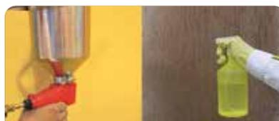
Salpicar con molinete o máquina tolvá en dos manos: una hasta cubrir el fondo con una capa pareja. Dejar orear. Si la textura deseada es planchada, pasar una llana plástica. Finalmente impermeabilizar con weber siliston S.
