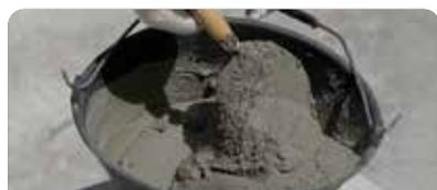
Amasar con aproximadamente 5 l de agua limpia por bolsa de 25 kg, manual o mecánicamente (batidor eléctrico lento: 500 rpm).
