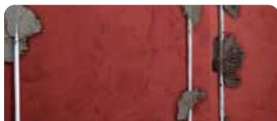
Colocar las reglas metálicas con el mismo material. Manual: mezclar con aprox. 12 L agua limpia, por bolsa. Dejar reposar y volver a mezclar. Projectada: regular el caudal de la máquina hasta lograr la consistencia adecuada (máquina M-Tec Duo Mix 550 L/hs aprox.).
