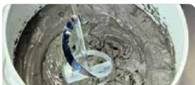
Colocar agua limpia en el balde, luego agregar **weber porcellanato flex** paulatinamente (6 l por bolsa aprox.) y mezclar manualmente o con batidor eléctrico (500 rpm) hasta obtener una pasta homogénea. Dejar reposar 5 minutos.
