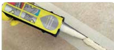
Cortar la punta del pico a bisel en la sección deseada. Introducir el conjunto en la pistola aplicadora. Rellenar la junta completamente, asegurándose de que el material quede en contacto con ambos lados de la misma.
