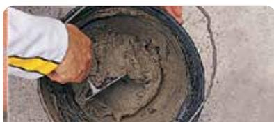
Amasar con aproximadamente 4,5/5,5 l de agua limpia por bolsa de 30 kg, manual o mecánicamente, hasta lograr una pasta homogénea. Dejar reposar entre 5 a 10 min aproximadamente.
