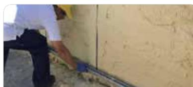
Reglear hasta conseguir una superficie plana, estable y homogénea. Retirar las guías y rellenar. Dejar secar como mínimo un día por cm de aplicación. Cubrir con weber forte o webertherm base coat para darle terminación. Finalizar con revestimiento weberplast en cualquiera de sus variantes.
