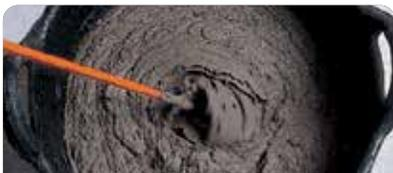
Amasar weber block utilizando de 4,5/5,1 l de agua por bolsa, manual o mecánicamente, hasta lograr una pasta homogénea y dejar reposar aprox. 5 min.
