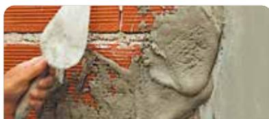
Aplicar con cuchara de albañil en capas sucesivas hasta obtener un espesor de aproximadamente 1,5 cm. Reglear y luego retirar las guías. Rellenar con el mismo material, presionando y asegurándose de no dejar huecos.
