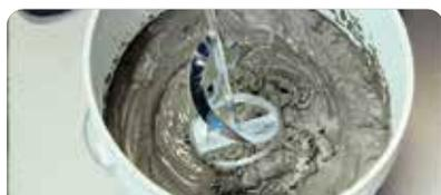
Colocar agua limpia en el balde. Luego, agregar **weber basic** paulatinamente (6 l por bolsa aprox.) y mezclar manualmente o con batidor eléctrico (500 rpm) hasta obtener una pasta homogénea. Dejar reposar 5 minutos.
