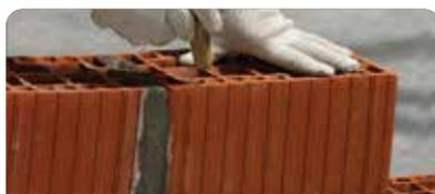
Como mortero de asiento: colocar la pasta sobre el ladrillo y asentarlo golpeando con el mango de la cuchara. Emproljar la junta.
