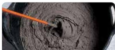
Amasar con aproximadamente 3,5 litros de agua limpia por bolsa de 25 kg, manual o mecánicamente (bati-dor eléctrico lento: 500 rpm) hasta obtener una mezcla homogénea.
