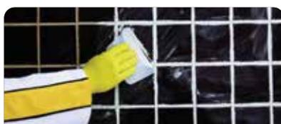
Llenar las juntas con una llana de caucho, extendiendo el producto en diagonal a éstas y presionando la masa para un rellenado completo.
