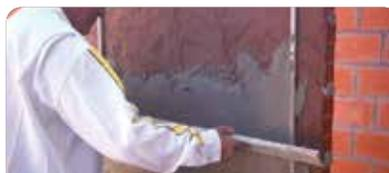
Solo reglear, no fratar. Retirar las guías y rellenar. Dejar secar como mínimo un día por cm de aplicación. En los puntos donde existiera riesgo de fisura, utilizar malla de fibra de vidrio para armar el mortero.
