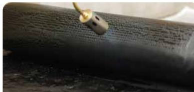
Calentar el rollo con soplete en la porción a aplicar hasta fundir completamente el antiadherente. Desenrollar la parte calentada y ejercer una leve presión para ayudar a la adherencia. Solapar el paño consecutivo no menos de 8 cm en sentido longitudinal. En los extremos de los rollos solapar 15 cm para evitar cualquier filtración.
