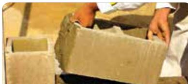
Distribuir el mortero sobre la capa superior del bloque ya colocado y en los laterales del bloque a colocar. Asentar este último ejerciendo presión para afirmarlo. Continuar hasta completar la hilada.
