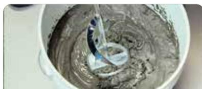
Colocar agua limpia en el balde. Luego, agregar weber gris paulatinamente (6 l por bolsa aprox.) y mezclar manualmente o con batidor eléctrico (500 rpm) hasta obtener una pasta homogénea. Dejar reposar 5 minutos.
