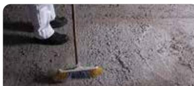
Pasadas 12 h, retirar el excedente de material barriéndolo, y finalmente lavar con agua a presión, con el mortero totalmente fraguado.
