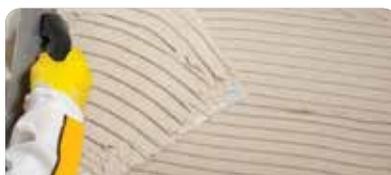
Extender sobre el soporte en paños chicos, 1 o 2 piezas por vez máximo, peinando con una llana dentada para regularizar el espesor. Pintar el reverso de la pieza con llana lisa.
