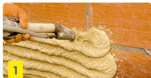
Colocar fajas secas a plomo cada 1,80 mts aprox. Regular el caudal de la máquina (Duo Mix: 800 L/h) y proyectar de manera uniforme para lograr una buena distribución. Si la aplicación es manual utilizar 6L de agua por bolsa.
