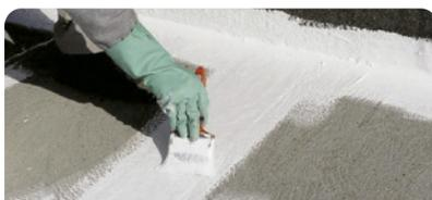
Aplicar 1 mano de imprimación diluida al 25% (3 partes de producto y 1 parte de agua) con rodillo, pincel o brocha. Dejar secar entre 2 a 4 horas dependiendo de la humedad y temperatura ambiente.
