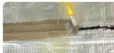
Soldar los solapes entre paños calentando con soplete, y luego, con una cuchara de albañil, presionar y distribuir el asfalto de exudado para sellar la unión. Aplicar **Megaflex pintura aluminizada** sobre todas las uniones de paños para proteger el asfalto expuesto al soldar.
