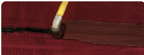
Aplicar una primera mano utilizando rodillo o pincel, cubriendo completamente la junta de la membrana asfáltica con revestimiento **NO CRACK color** instalada previamente. Aplicar una segunda mano permitiendo completar un adecuado sistema de impermeabilización.
