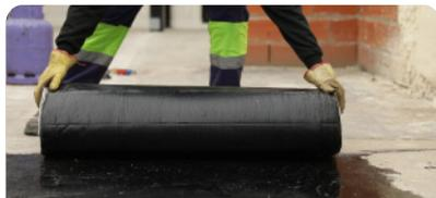
Impermeabilizar con **Megaflex Pintura asfáltica** o **Megaflex Emulsión asfáltica**, según el sustrato, previamente todos los desagües. Luego, colocar los rollos desde la parte más cercana a los mismos hacia la parte más alejada, en forma perpendicular a la pendiente. Extender el rollo a aplicar por completo para verificar su correcta posición. Enrollarlo nuevamente.
