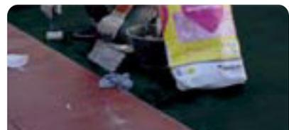
Soldar los solapes entre paños calentando con soplete, y luego, con una cuchara de albañil, presionar y distribuir el asfalto de exudado para sellar la unión. Esta membrana no es apta para quedar expuesta a la intemperie y por lo tanto deberá recibir una terminación superficial constituyendo un sistema donde la membrana repose debajo de otro elemento. Una vez aplicado el producto, será necesario fundir el polietileno expuesto con soplete, para mejorar la mordiente para el mortero posterior.
