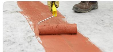
Soldar los solapes entre paños calentando con soplete, y luego, con una chuchara de albañil, presionar y distribuir el asfalto de exudado para sellar la unión. Aplicar **Megaflex pintura geotrans** toda la superficie para revestir el geotextil y protegerlo de los rayos solares y del tránsito peatonal.
