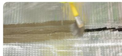
Soldar los solapes entre paños calentando con soplete, y luego, con una cuchara de albañil presionar y distribuir el asfalto de exudado para sellar la unión. Aplicar **Megaflex pintura aluminizada** para membranas con revestimiento aluminio y para revestimiento color aplicar **Megaflex pintura NO CRACK** color sobre todas las uniones de paños para proteger el asfalto expuesto al soldar.
