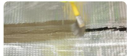
Soldar los solapes entre paños calentando con soplete, y luego, con una cuchara de albañil, presionar y distribuir el asfalto de exudado para sellar la unión. Aplicar **Megaflex pintura aluminizada** para membranas con revestimiento de aluminio y **Megaflex pintura NO CRACK Color** para membranas con revestimiento color, sobre todas las uniones de paños para proteger el asfalto expuesto al soldar.
