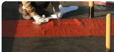
Retirar la primera mitad del antiadherente progresivamente a medida que se va pegando el rollo sobre la superficie. Luego quitar la segunda mitad y pegar. Solapar el paño consecutivo no menos de 8 cm en sentido longitudinal. En los extremos de los rollos solapar 15 cm para evitar cualquier filtración.
