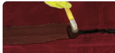
Soldar los solapes entre paños calentando con soplete, y luego, con una cuchara de albañil, presionar y distribuir el asfalto de exudado para sellar la unión. Aplicar **Megaflex pintura aluminizada** para membranas aluminizadas o **Megaflex pintura NO CRACK COLOR** para membranas con revestimiento color, sobre todas las uniones de paños para proteger el asfalto expuesto al soldar.
