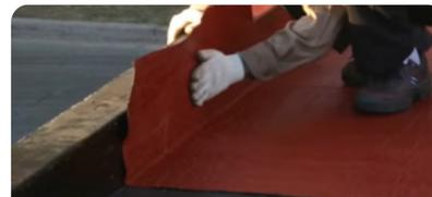
Realizar el embabetado en los muros perimetrales. Los encuentros entre el piso y pared se resolverán con doble membrana de modo que la terminación en los mismos sea redondeada.
