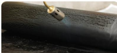
Calentar el rollo con soplete en la porción a aplicar hasta fundir completamente el antiadherente. Desenrollar la parte calentada y ejercer una leve presión para ayudar a la adherencia. Solapar el paño consecutivo no menos de 8 cm en sentido longitudinal. En los extremos de los rollos solapar 15 cm para evitar cualquier filtración.
