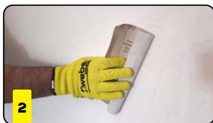
**2. Superficies Nuevas:** lijar para eliminar restos mal adheridos o excedentes de obra, en caso de presencia de salitre se recomienda lavar la pared con una solución de ácido muriático al 10% y luego enjuagar perfectamente. Dejar secar.
