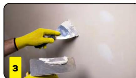
**3. Superficies Nuevas:** con llana, extender capa delgada de **tacurú enduido plástico interior** de abajo hacia arriba. Dejar secar y lijar suavemente. Si es necesario, aplicar la 2ª mano, secar 24 horas y volver a lijar.
