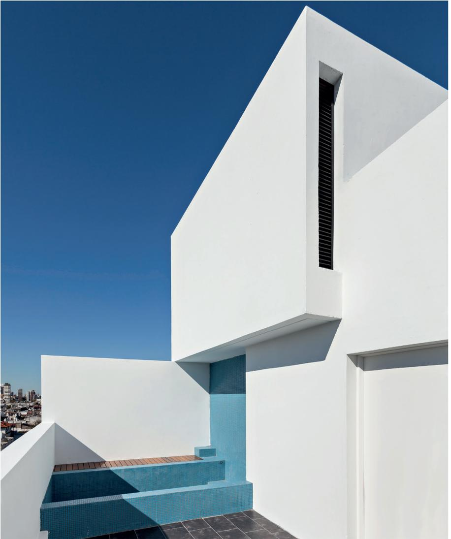
El tabique frontal de hormigón visto gira en la parte superior de la fachada conteniendo, hacia afuera, a los balcones, y ocultando tras de sí una terraza-patio del dormitorio principal del triplex. Este departamento ático va a permitir explorar otra de las búsquedas insistentes de los autores a partir del
