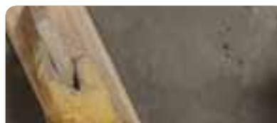
Cubrir con el revoque posterior en el lapso de las 12 y 48h de aplicado el imprimante. Es muy importante respetar el tiempo abierto del producto.
