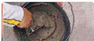
Amasar con aproximadamente 4,5/5,5 l de agua limpia por bolsa de 30 kg, manual o mecánicamente, hasta lograr una pasta homogénea. Dejar reposar entre 5 a 10 min aproximadamente.
