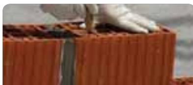
Como mortero de asiento: colocar la pasta sobre el ladrillo y asentarlo golpeando con el mango de la cuchara. Emprolijar la junta.
