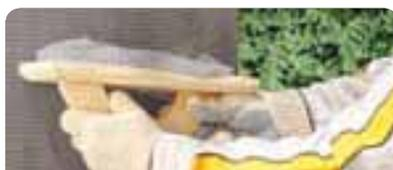
Extender de modo uniforme el producto con frataso de madera en dos manos hasta obtener un espesor de aproximadamente 3 mm.
