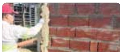
Colocar las reglas metálicas con el mismo material. **Aplicación manual:** preparar la mezcla con agua limpia, aproximadamente 5,5 a 6 l por bolsa. **Aplicación proyectada:** regular la máquina hasta lograr la consistencia adecuada.
