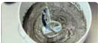
Colocar agua limpia en el balde. Luego, agregar **weber pro** paulatinamente (6 l por bolsa aprox.) y mezclar manualmente o con batidor eléctrico (500 rpm) hasta obtener una pasta homogénea. Dejar reposar 5 minutos.
