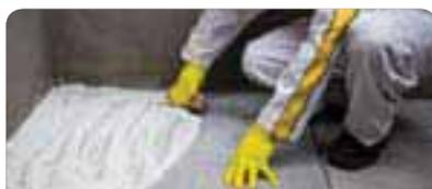
Españar el producto con una llana dentada n° 4 o rodillo dentado, sobre la superficie ya nivelada con **weber top** o **weber masa plus**.
