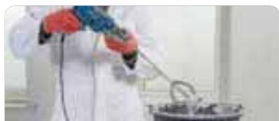
Mezclar el producto con 5 litros de agua por bolsa de 25 kg con un batidor eléctrico lento (500 rpm), hasta obtener una pasta fluida y homogénea. Mantener constante esta proporción durante toda la aplicación. Dejar reposar la mezcla 2 minutos.
