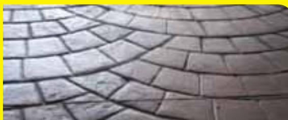
La técnica del estampado o impresión de pisos consiste en, una vez colado el mortero o espolvoreado el hormigón (según si se estampará sobre **weber alisado color** o **weber print XC**), poner sobre la superficie aún plástica moldes flexibles de diversas texturas (adoquín, laja, baldosas, etc.) presionando y levantando para dejar el diseño del molde impreso sobre la superficie. Los moldes de estampado se fabrican en diversos tamaños y formas. Otorgan textura y diseño.
