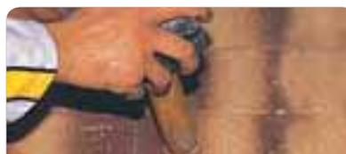
Colocar las piezas refractarias, presionar y nivelar la superficie. Empastinar con el mismo material 48 h posteriores a la colocación y 48 h después se sugiere dar fuego para mejorar el endurecimiento. Proteger de las lluvias hasta tanto no haya endurecido.
