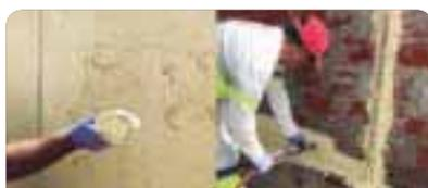
**Aplicación manual:** comenzar aplicando el material presionando con una llana metálica sobre la pared, luego cucharar el resto. **Aplicación proyectada:** comenzar a proyectar desde abajo hacia arriba y de manera uniforme. Espesor máximo de aplicación por capa: 40 mm.
