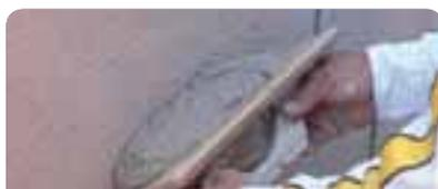
Extender el producto, de abajo hacia arriba, con frataso de madera clara en dos manos hasta obtener un espesor de 2 mm.
