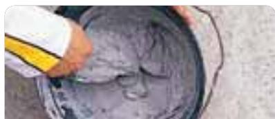
Colocar agua limpia en un balde y luego agregar **weber yeso GF** paulatinamente. Utilizar un volumen de agua cada 2 volúmenes de **weber yeso GF**. Mezclar manual o mecánicamente hasta obtener una pasta homogénea.
