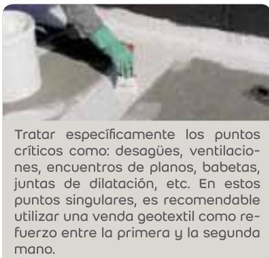
Tratar específicamente los puntos críticos como: desagües, ventilaciones, encuentros de planos, babetas, juntas de dilatación, etc. En estos puntos singulares, es recomendable utilizar una venda geotextil como refuerzo entre la primera y la segunda mano.
