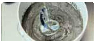
Colocar agua limpia en el balde. Luego, agregar **weber gris** paulatinamente (6 l por bolsa aprox.) y mezclar manualmente o con batidor eléctrico (500 rpm) hasta obtener una pasta homogénea. Dejar reposar 5 minutos.
