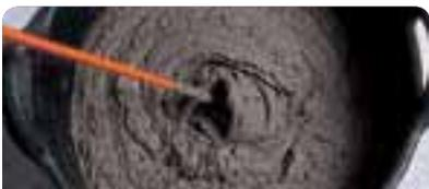
Amasar con aproximadamente 7 a 7,5 litros de agua limpia por bolsa de 25 kg. Mezclar manual o mecánicamente hasta conseguir una masa homogénea.
