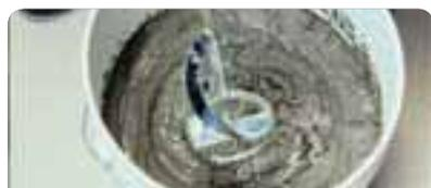
Colocar agua limpia en el balde. Luego, agregar **weber basic** paulatinamente (6 l por bolsa aprox.) y mezclar manualmente o con batidor eléctrico (500 rpm) hasta obtener una pasta homogénea. Dejar reposar 5 minutos.
