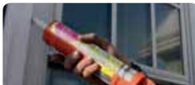
Cortar la punta del pico a bisel en la sección deseada. Introducir el conjunto en la pistola aplicadora.
