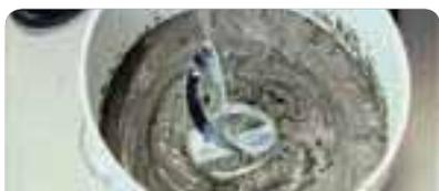
Colocar agua limpia en el balde, luego agregar **weber superflex** paulatinamente (6 l por bolsa aprox.), mezclar manualmente o con batidor eléctrico (500 rpm) hasta obtener una pasta homogénea. Dejar reposar 5 minutos.
