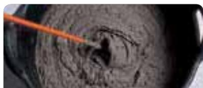
Amasar con aproximadamente 3,5 litros de agua limpia por bolsa de 25 kg, manual o mecánicamente (batedor eléctrico lento: 500 rpm) hasta obtener una mezcla homogénea.
