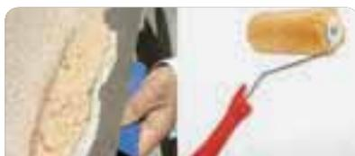
Extender el revestimiento con llana metálica, hasta lograr el espesor determinado por su granulometría. Aplicación a rodillo de **RTF**. Rodillo de goma espuma: 2 manos diluidas con 20 % de agua. Rodillo de lana de pelo corto: 1 mano diluida con 10 % de agua. Rodillo de lana de pelo largo: 1 mano sin diluir.
