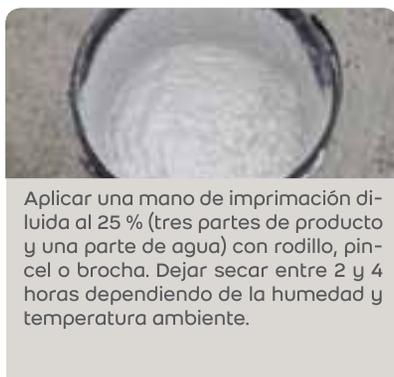
Aplicar una mano de imprimación diluida al 25% (tres partes de producto y una parte de agua) con rodillo y una parte de agua) con rodillo, pincel o brocha. Dejar secar entre 2 y 4 horas dependiendo de la humedad y temperatura ambiente.
