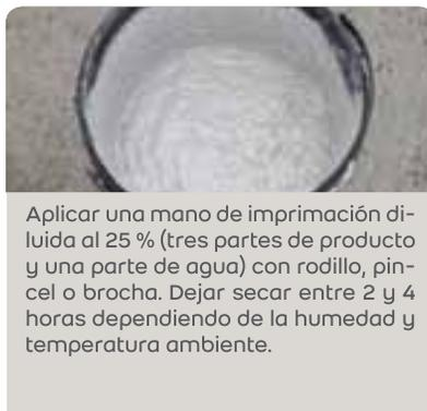
Aplicar una mano de imprimación diluida al 25 % (tres partes de producto y una parte de agua) con rodillo, pincel o brocha. Dejar secar entre 2 y 4 horas dependiendo de la humedad y temperatura ambiente.
