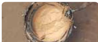
Amasar **weber super iggam** con aprox. 6,5 l de agua por bolsa de material, manual o mecánicamente, hasta lograr una pasta homogénea y dejar reposar entre 5/10 min.
