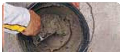
Preparar la superficie a revocar con guías, fajas secas o húmedas. Amasar **weber mix E** utilizando de 4,5/5,5 l de agua por cada bolsa de 30 kg, manual o mecánicamente, hasta lograr una pasta homogénea.
