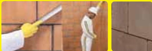
Hay soportes que requieren un tratamiento diferencial, como por ejemplo el hormigón armado o los ladrillos de hormigón celular (HCCA), entre otros. El hormigón, por ser de baja absorción, requiere el uso de promotores de adherencia antes de comenzar con el revoque. En el caso de los bloques HCCA, la absorción es muy rápida con lo cual también necesitaremos un promotor de adherencia previo al revoque o bien utilizar productos diseñados especialmente para esos soportes.
