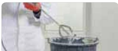
Mezclar con batidor manual el contenido del envase para evitar la sedimentación del producto. Limpiar a fondo la superficie a aplicar, eliminando polvo y suciedades. En caso de existir partes flojas, eliminarlas y reparar.
