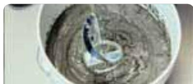
Colocar agua limpia en el balde, luego agregar **weber porcellanato** paulatinamente (6 l por bolsa aprox.) y mezclar manualmente o con batidor eléctrico (500 rpm) hasta obtener una pasta homogénea. Dejar reposar 5 minutos.
