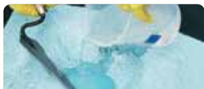
Colocar agua limpia en el balde, luego agregar **weber veneciano** paulatinamente (7 l por bolsa aprox.), mezclar manualmente o con batidor eléctrico (500 rpm) hasta obtener una pasta homogénea y de coloración uniforme. Preparar solo de a 1 balde chico para garantizar la vida de la pasta.
