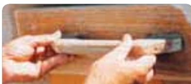
Extender el producto, de abajo hacia arriba, con frataso de madera clara en dos manos hasta obtener un espesor de 4/5 mm. Dejar orear y fratar el material antes de que empiece a endurecer.
