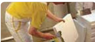
Como adhesivo: extender el **webertherm base coat** gris sobre la pared y el reverso de la placa, con la parte ciega de la llana N° 10. Ranurar con la parte dentada. Apoyar la placa y presionar.
