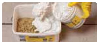
Mezclar la totalidad del componente A con el B hasta obtener una masa homogénea sin agregar agua ni diluyentes. Si se utiliza en forma parcial, mezclar dos partes de A + una de B. La mezcla deberá ser aplicada en su totalidad (retirar el excedente durante la primera hora a partir del mezclado).
