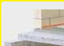
✓ Juntas de asentamiento: es el espacio que se debe dejar entre piezas; se debe respetar la junta recomendada por el fabricante (en piezas absorbentes, nunca menor a 3 mm). Utilizar cruces separadoras para garantizar la junta hasta la base de las placas. Relleno: se utilizan pastinas cementicias o epoxídicas.
