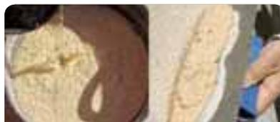
Amasar **weber texturable** con aprox. 5,5/6 l de agua por cada bolsa en forma manual o mecánicamente hasta lograr una pasta homogénea y dejar reposar aprox. entre 5/10 min. Luego cargar el producto, de abajo hacia arriba, con lana metálica flexible.
