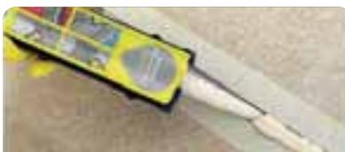
Cortar la punta del pico a bisel en la sección deseada. Introducir el conjunto en la pistola aplicadora. Rellenar la junta completamente, asegurándose de que el material quede en contacto con ambos lados de la misma.
