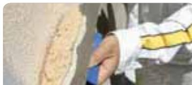
Extender el material con llana metálica de manera uniforme sobre la superficie hasta lograr el espesor determinado por la granulometría del producto. Se deben aplicar dos manos del producto con llana metálica.
