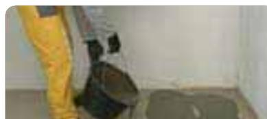
Verter la mezcla sobre el sustrato. Extender y alisar con el rastrillo nivelador. Utilizar el rodillo de púas para eliminar el aire del producto. Dejar secar.
