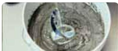
Colocar agua limpia en el balde, luego agregar **weber piso sobre piso 12 hs** paulatinamente (6 l por bolsa aprox.) y mezclar manualmente o con batidor eléctrico (500 rpm) hasta obtener una pasta homogénea. Dejar reposar 5 minutos.
