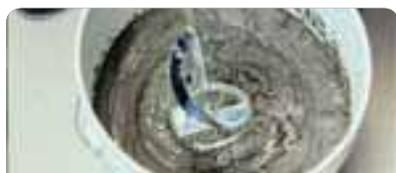
Mezclar el producto con 7,5 litros de agua por bolsa de 25 kg con un batidor eléctrico lento (500 rpm), hasta obtener una pasta fluida y homogénea. Mantener constante esta proporción durante toda la aplicación.
