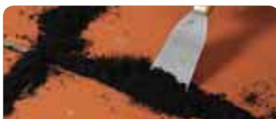
Rellenar las juntas con una espátula pequeña, cuidando de no manchar la superficie. Compactar la masa con un toma juntas, retirar el excedente y humedecer con agua en forma de rocío, hasta que aparezca el brillo superficial. Volver a humedecer a las 6 horas.
