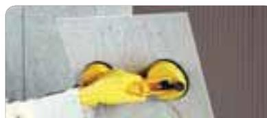
Colocar las piezas, presionarlas y moverlas de arriba hacia abajo, hasta conseguir el aplastamiento de los surcos, dejando la junta recomendada por el fabricante de las piezas (mínimo 3 mm). Luego de 24/48 h, tomar las juntas con **weber prestige** o **weber epoxi plus**.
