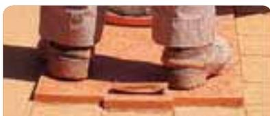
Imprimir ejerciendo presión sobre el molde. Levantar, y continuar imprimiendo.
