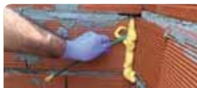
Una vez que la espuma se haya endurecido, retirar el exceso con algún elemento cortante: sierra, cuchillo, etc.
