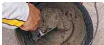
Colocar agua limpia en el balde, luego incorporar **weber refractarios** y mezclar manual o mecánicamente hasta obtener una pasta homogénea (1 l de agua limpia cada 5 kg).
