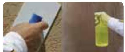
Dejar orear y texturar el material con lana plástica, obteniendo la textura deseada. Y finalmente impermeabilizar con **weber siliston S**.
