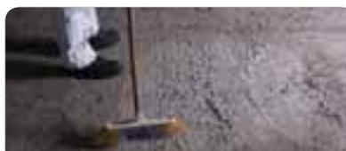
Pasadas 12 h, retirar el excedente de material barriéndolo, y finalmente lavar con agua a presión, con el mortero totalmente fraguado.
