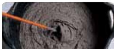
Amasar el material con mezcladora continua, manual o mecánicamente, con aprox. 4,5 a 5,5 l de agua por bolsa (para mortero de asiento), y aprox. 5,2/6,4 l de agua por bolsa (para carpeta).
