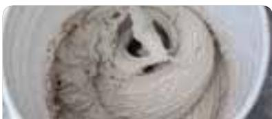
Colocar agua limpia en el balde, luego agregar **weber mármol** paulatinamente (6 l por bolsa aprox.) Mezclar hasta obtener una pasta homogénea. Dejar reposar.
