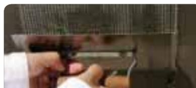
Como revoque base: sobre EPS dar una primera mano de **webertherm base coat** gris, con una llana metálica con un espesor de 2 mm aprox. y dejar orear. Colocar malla de fibra de vidrio y aplicar una segunda capa que cubra la malla.
