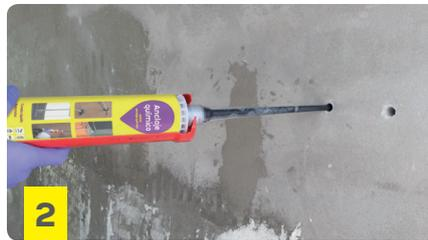
Liberar unos 5 cm de material o hasta que el anclaje se mezcle completamente. Aplicar dentro de la perforación o grieta.
