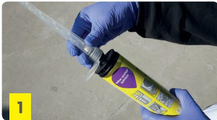
Retirar la tapa del envase y enroscar la boquilla mezcladora para su aplicación. Colocar el envase en la pistola aplicadora. Si el sustrato donde instalará el anclaje no es macizo se debe utilizar la canastilla para contener el material.
