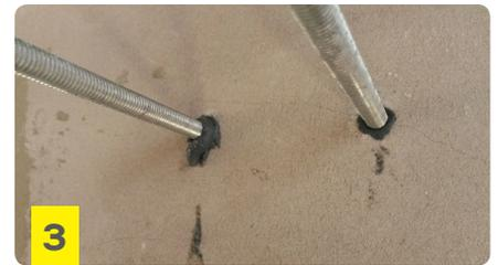
Insertar la fijación entre 3 y 8 minutos de aplicado el material dentro de la perforación. Limpiar el exceso de material.
