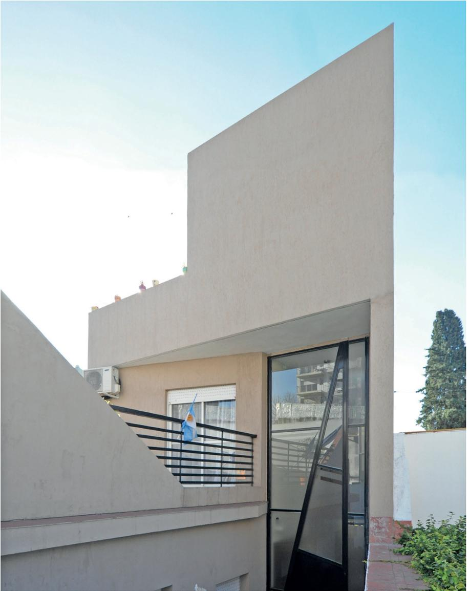
La ampliación se realizó con mampostería de ladrillos revocados y losas de viguetas. Excepto estas tareas, consideradas de albañilería “gruesa”, el resto de los elementos de la construcción como aberturas, escaleras,
