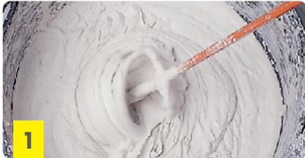
Amasar con aproximadamente 6/7 ltrs de agua limpia por bolsa de 25kg, manual o mecánicamente, hasta lograr una pasta homogénea. Dejar reposar aproximadamente 10 min.
