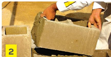
Distribuir el mortero sobre la capa superior del bloque ya colocado y en los laterales del bloque a colocar. Asentar este último ejerciendo presión para afirmarlo. Continuar hasta completar la hilada.
