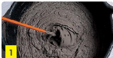
Amasar weber.rev block utilizando de 4,5/5,1 L de agua por bolsa, manual o mecánicamente, hasta lograr una pasta homogénea y dejar reposar aprox. 5 min.
