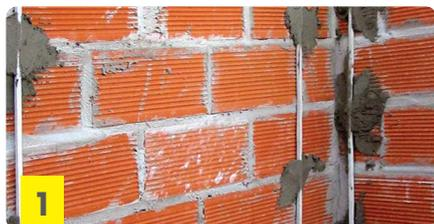
Colocar las reglas metálicas con el mismo material. Manual: mezclar con aprox. 12L agua limpia, por bolsa. . Dejar reposar y volver a mezclar. Proyectada: regular el caudal de la máquina hasta lograr la consistencia adecuada (máquina M-Tec Duo Mix 550 L/hs aprox.).
