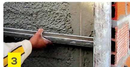
Sólo reglear, no fratar. Retirar las guías y rellenar. Dejar secar como mínimo un día por cm de aplicación. En los puntos donde existiera riesgo de fisuración, utilizar malla de fibra de vidrio para armar el mortero.
