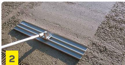
En cada espolvoreo, introducirlo enérgicamente dentro del hormigón mediante el uso de llanas de magnesio o aluminio (incorporación manual), o con el plato del helicóptero (incorporación mecánica).
