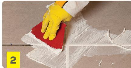
Con ayuda de una espátula o llana de caucho, aplicar en juntas de 2 a 15 mm en forma diagonal, presionando para lograr un completo relleno. Retirar el excedente.
