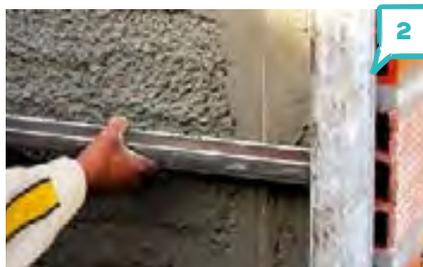
2 Cuando el material haya "tirado", aplicar la segunda capa hasta conseguir el espesor deseado. (si el espesor total es mayor a 40 mm se aconseja aplicar una nueva capa). Reglear.
