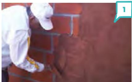
1 Realizar el azotado hidrófugo con ceresita o weber.tec ceresita. Mezclar "weber.therm climamur" con agua limpia y colocarlo en una primera capa.
