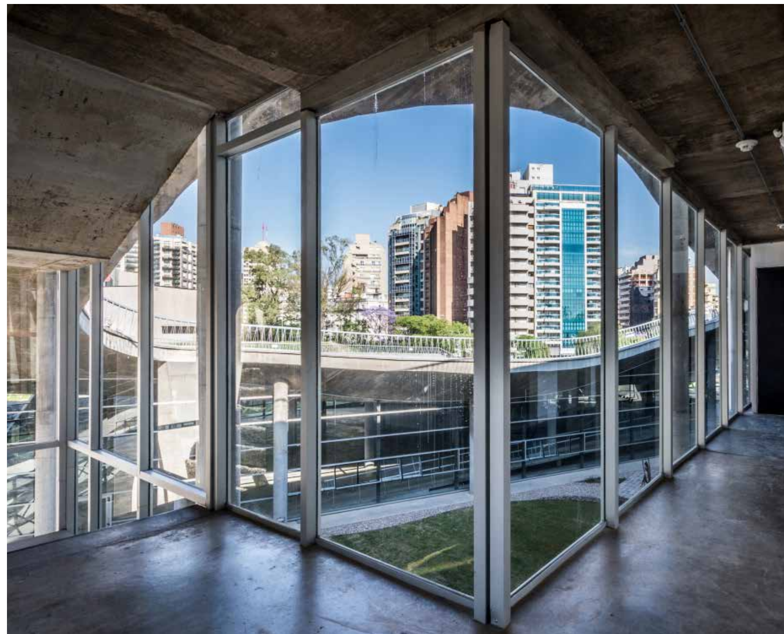
El hueco de la plaza/techo que conforma el patio interior del Pabellón genera vistas diagonales y dinámicas en todas las direcciones.
