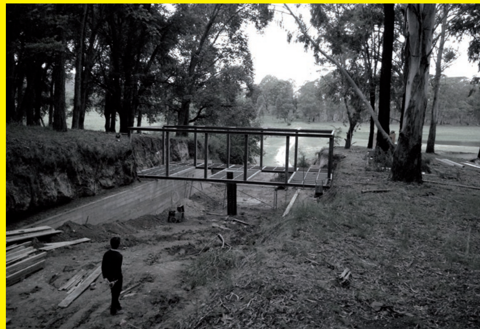
/Fotografía: alarcia | ferrer arquitectos Pabellón puente en construcción
