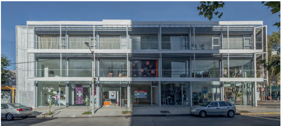
88/ Locales y Oficinas Comerciales Alvear
