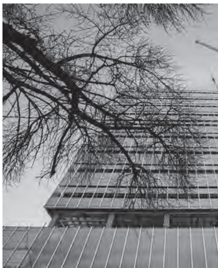
/Nueva Sede BPN - Edificio Torre
