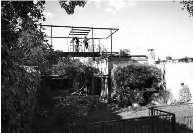
/Proceso de construcción de la estructura de la Casa Palos
